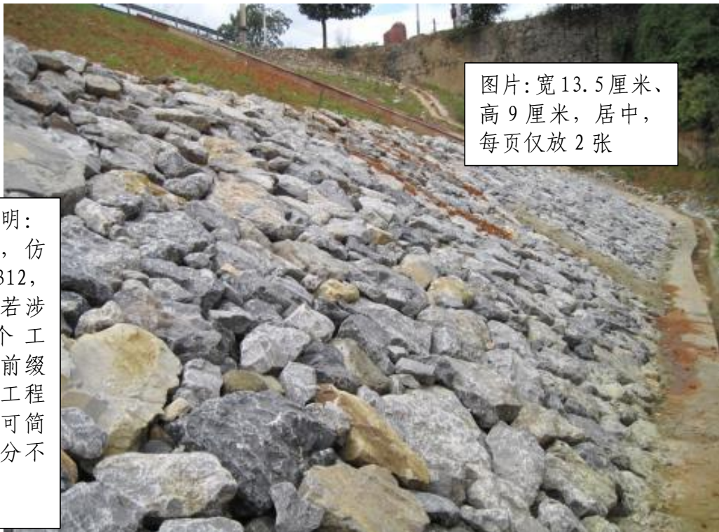
× × 质量管理图 1-1 贴坡排水砌筑全貌
