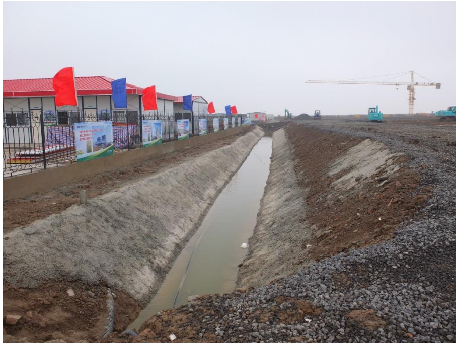
浆砌石排洪沟（2016年6月）
