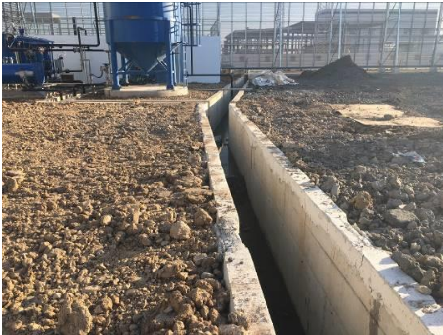
钢筋混凝土排水沟（2017年12月）
