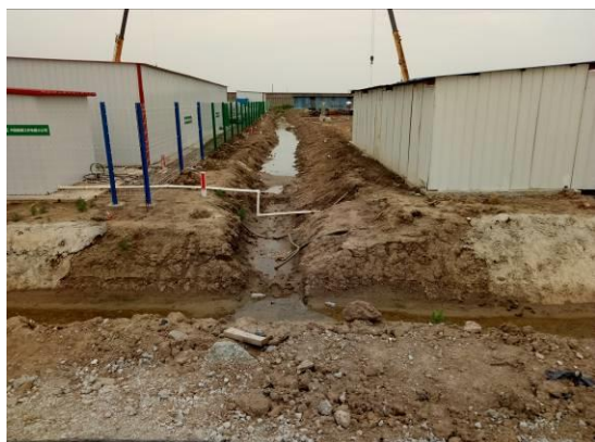
临时排水沟（2016年5月）
