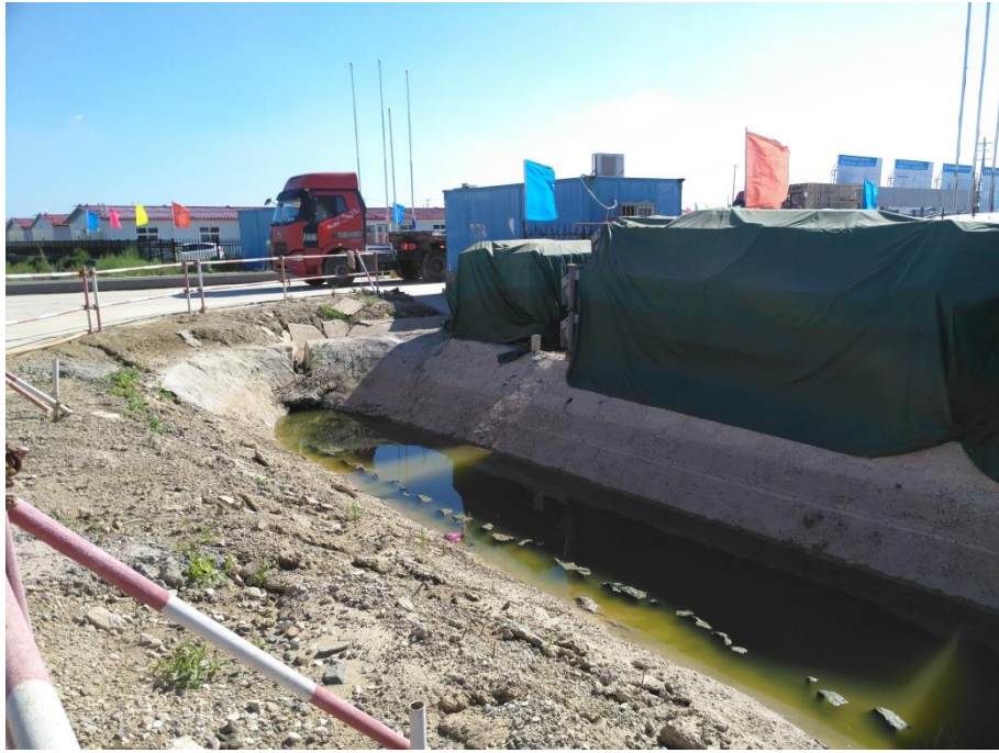
土工布苫盖（2017年9月）
