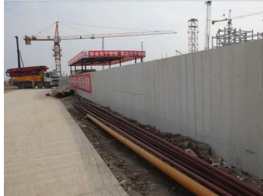
挡板拦挡 (2016年7月)
