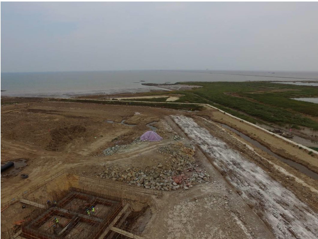
临时排水沟、海堤采取临时覆盖措施
