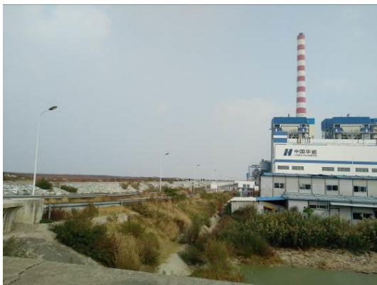
进场道路植被恢复
