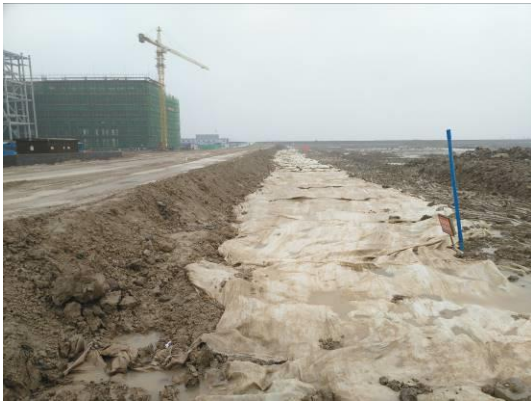
防雨布临时覆盖堆填土
