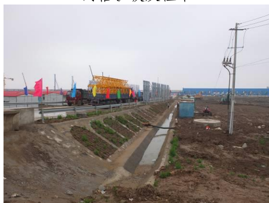
浆砌石排洪沟
