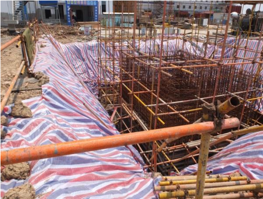
新增防雨布基坑边坡临时苫盖
