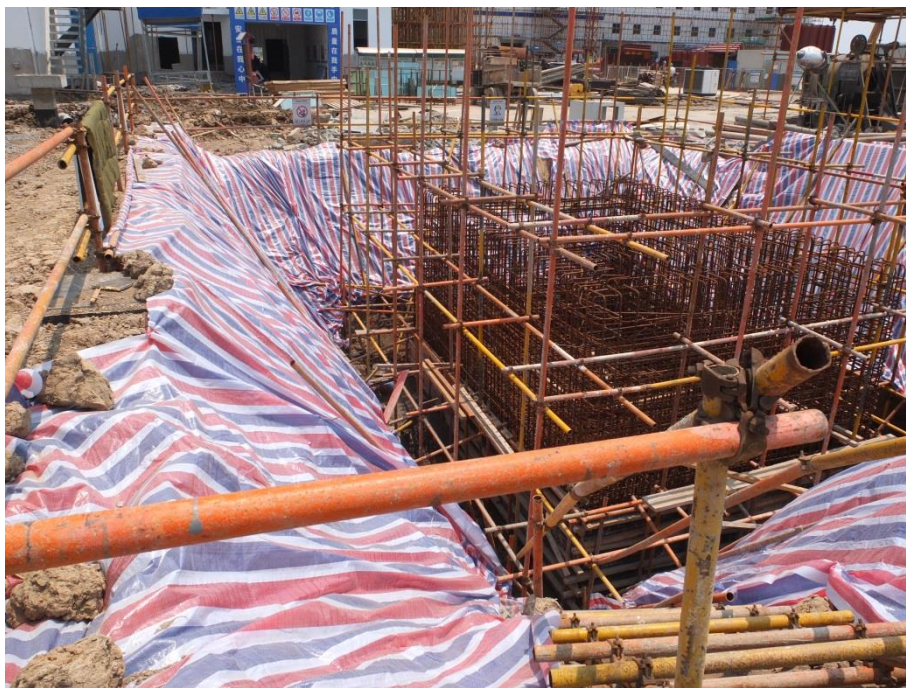
防雨布苫盖（2017年6月）
