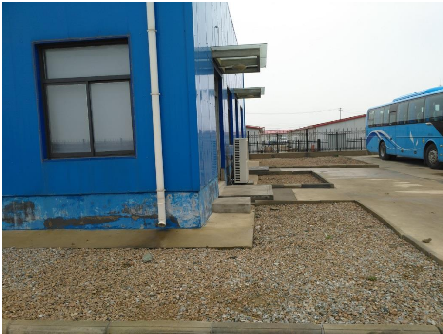
碎石铺设（2017年3月）
