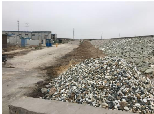
厂区北侧防浪堤施工
