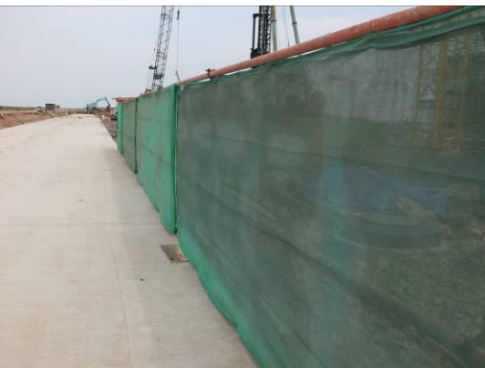
防护网拦挡 (2016年7月)
