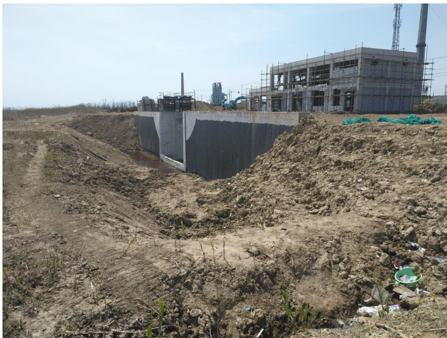
取水泵站施工（2017年4月）
