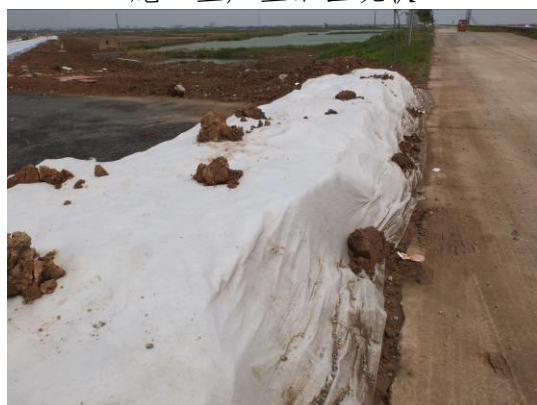
防雨布临时覆盖
