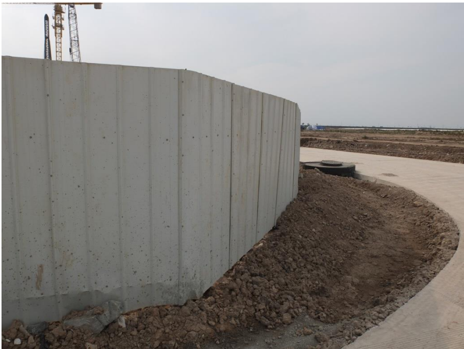
挡板拦挡（2016年9月）
