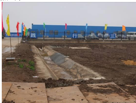
施工生产生活区现状
