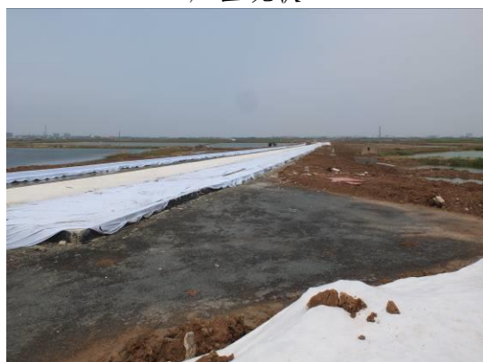
厂外道路施工
