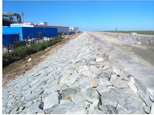
厂区四周防浪堤
