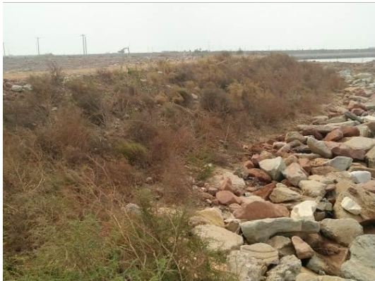
灰常灰坝坡面植被恢复
