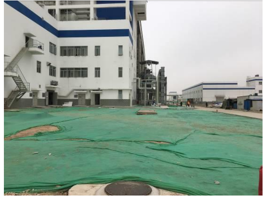
厂区密目网覆盖
