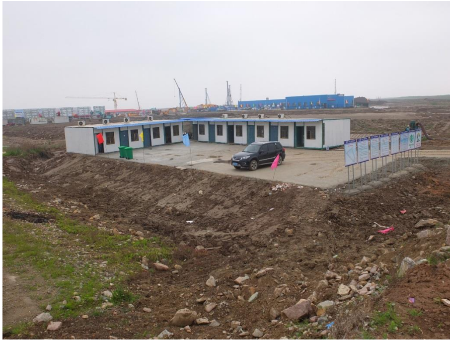
施工生产生活区（2016年6月）
