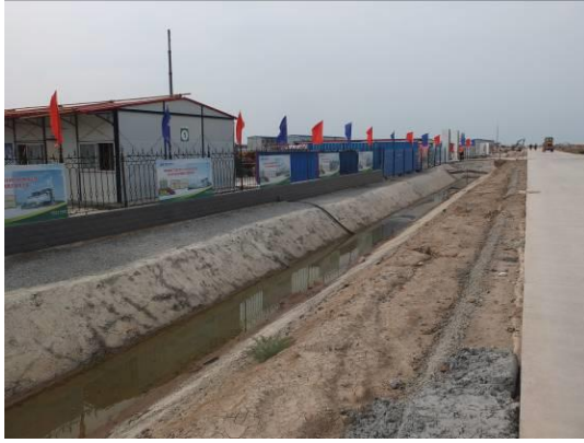
浆砌石排洪沟（2016年5月）
