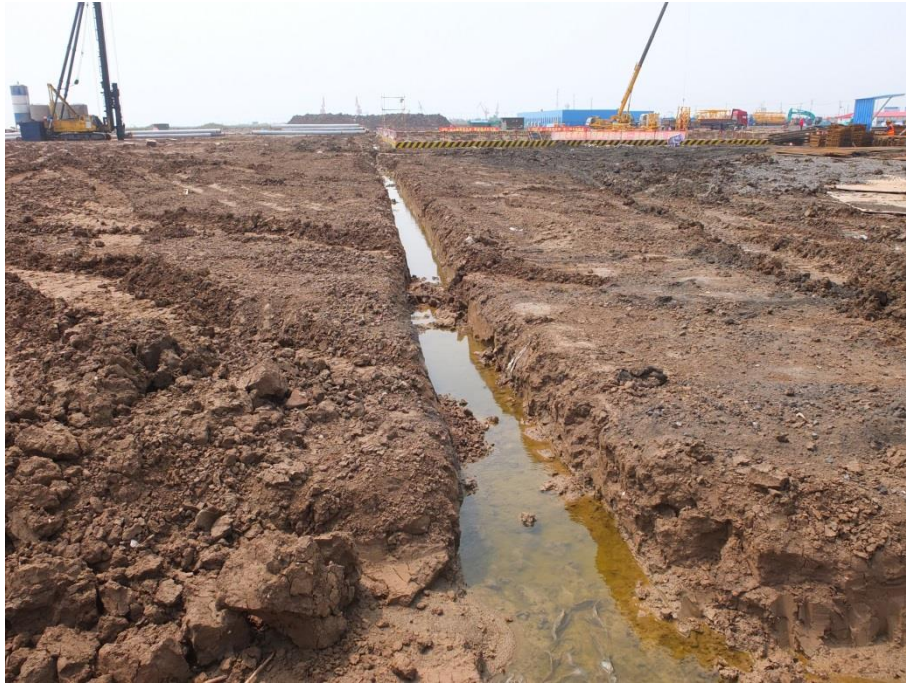
临时排水沟（2016年6月）
