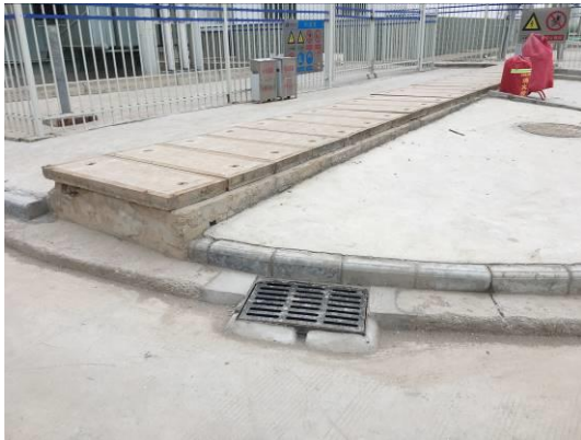
厂区钢筋混凝土排水沟道
