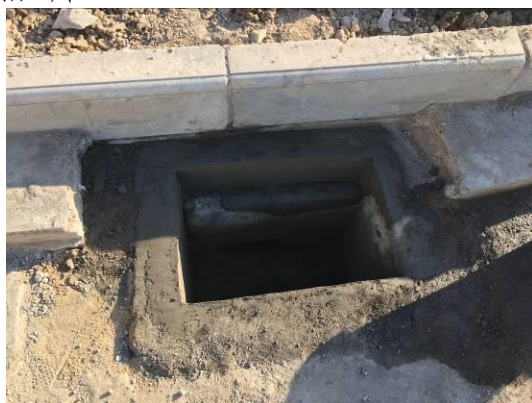
厂区 pvc 排水管道施工
