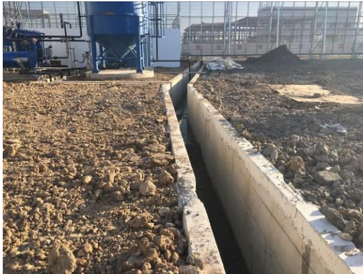
厂区钢筋混凝土沟（2017年12月）
