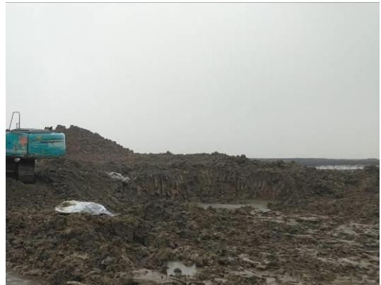
厂区东北侧临时堆土外围缺乏临时拦挡及排水措施，应予以补充
