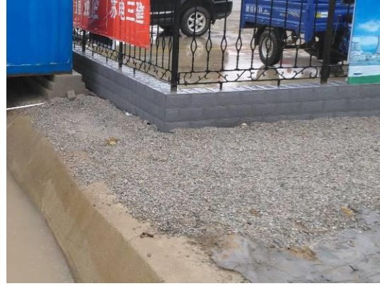
碎石铺设（2017年6月）
