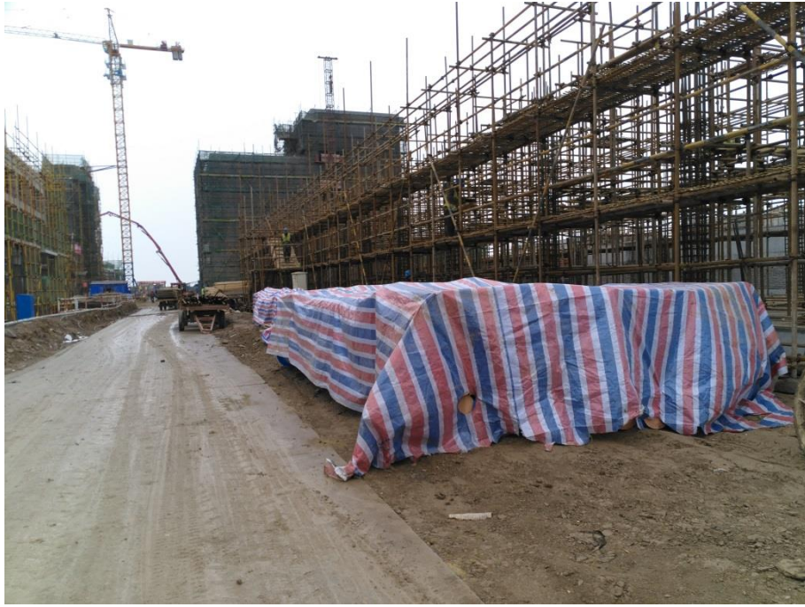
防雨布苫盖（2017年3月）
