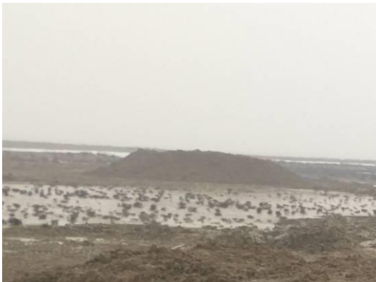
临时堆土缺乏拦挡和覆盖措施，建议增设装土编织袋拦挡及覆盖措施
