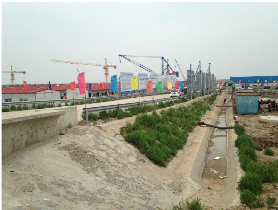
网格植草护坡及浆砌石排水沟（2016年7月）
