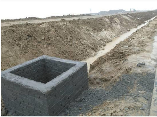
防浪墙沉砂池
