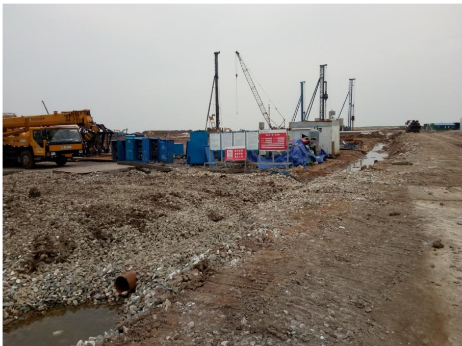
碎石铺设（2016年7月）
