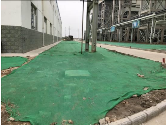
厂区密目网覆盖
