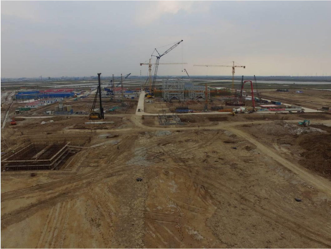
厂区施工情况
