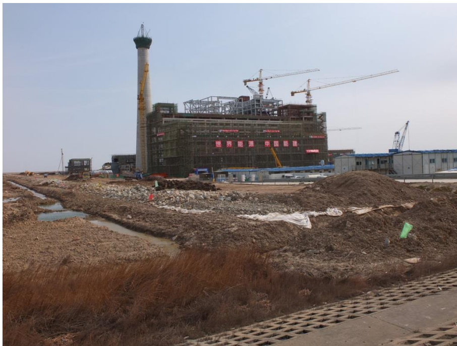
临时排水沟（2017年2月）
