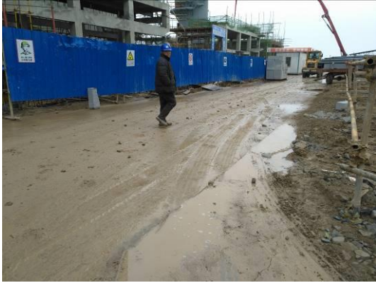
临时挡板拦挡措施
