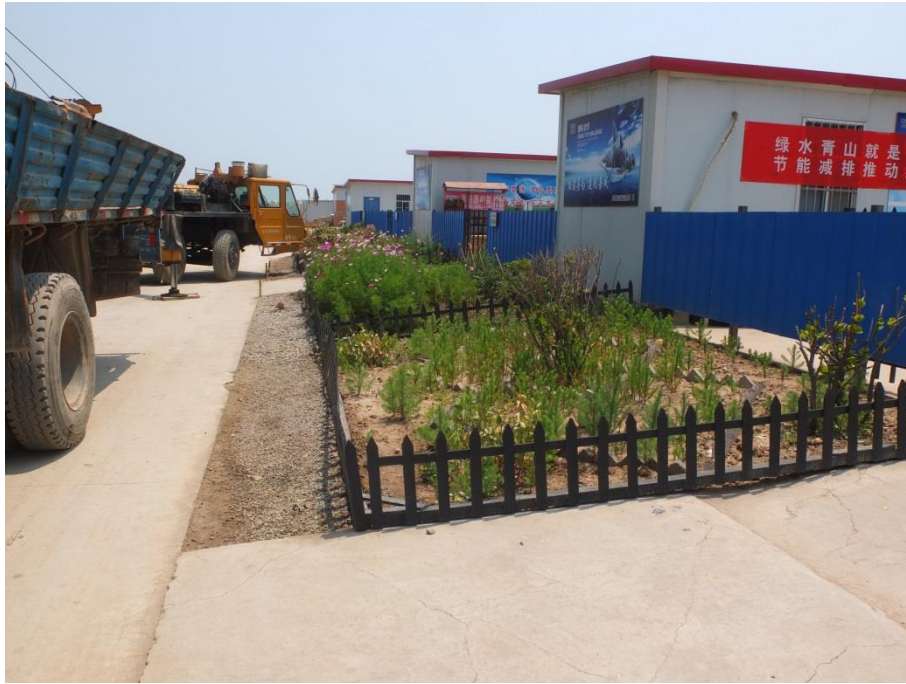
施工生产生活区临时绿化（2017年6月）
