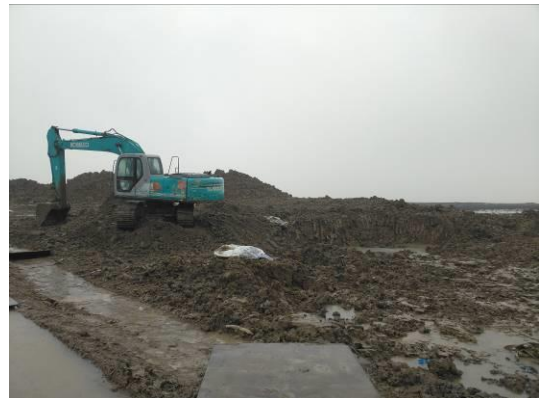
临时堆土缺乏拦挡和覆盖措施，建议增设装土编织袋拦挡及覆盖措施
