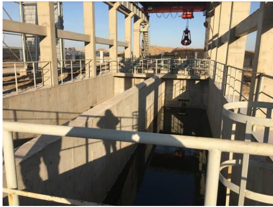
煤水沉清池 (2017年10月)
