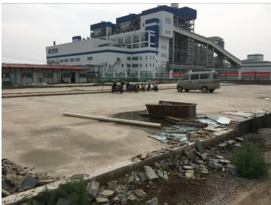
施工生产生活区拆除后应尽快迹地整治
