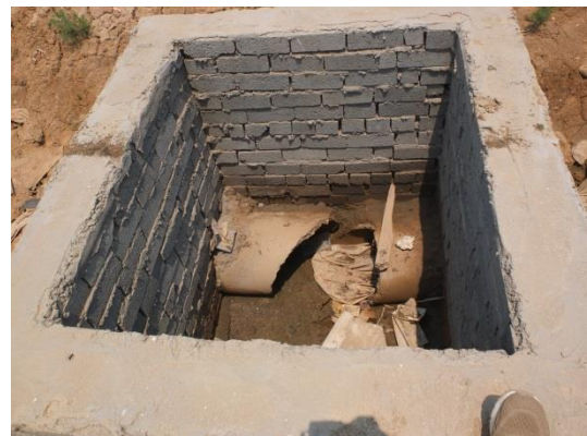
防浪墙沉砂池（2016年10月）
