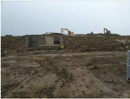
厂区东北侧临时堆土外围缺乏临时拦挡及排水措施，应予以补充
