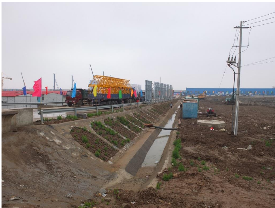
网格植草护坡及浆砌石排水沟（2016年6月）
