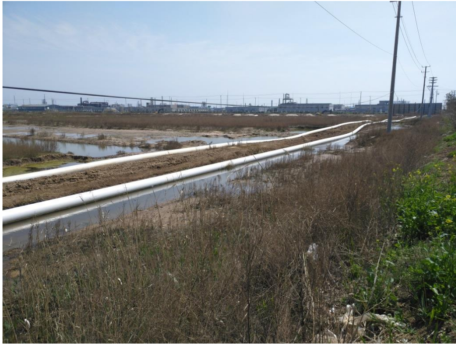
厂外管线区施工（2017年4月）
