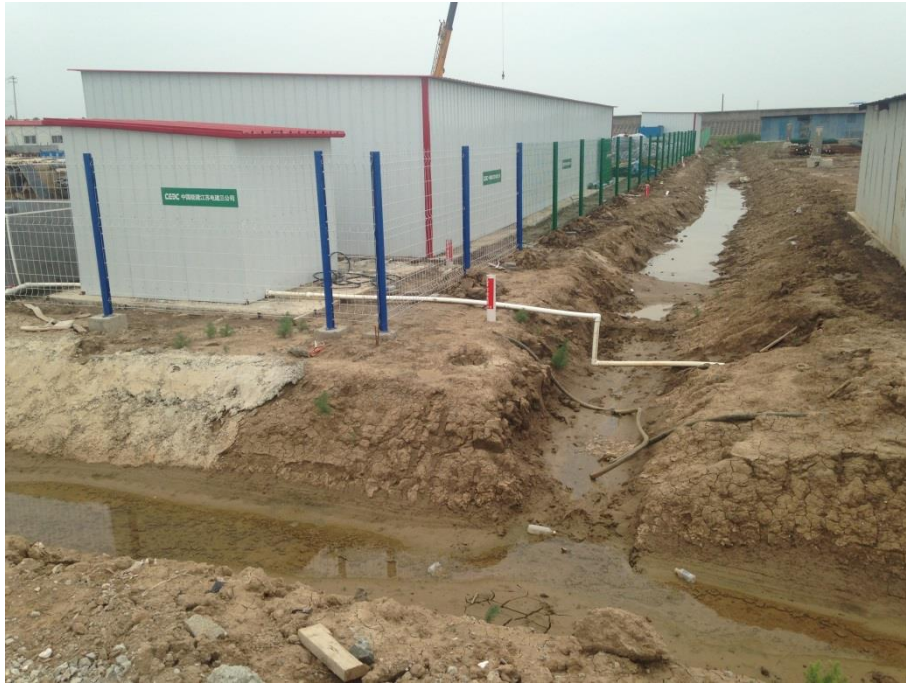
临时排水沟（2016年7月）
