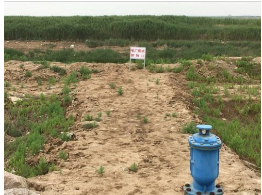
厂区雨水排放口
