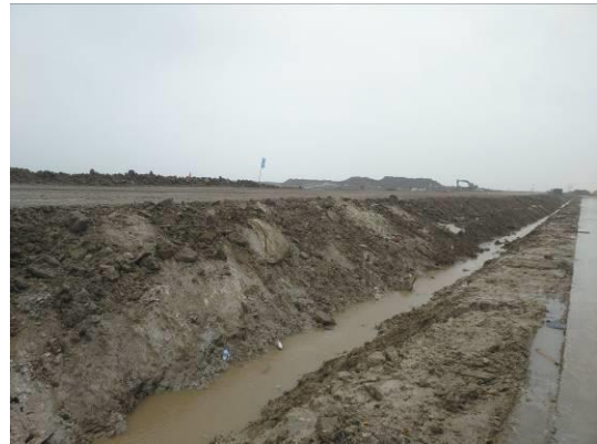
土质开挖排水沟
