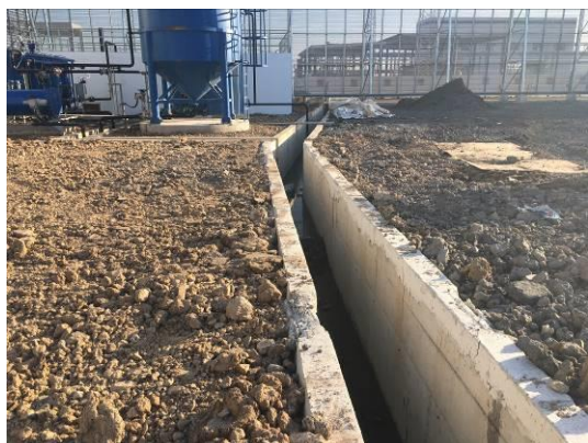
厂区钢筋混凝土沟道
