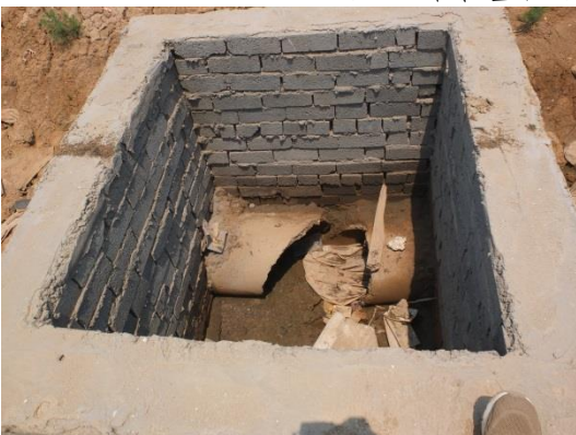
防浪墙沉砂池
