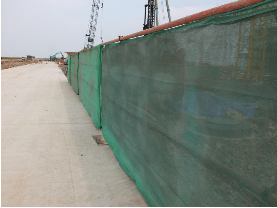
防护网拦挡（2016年9月）
