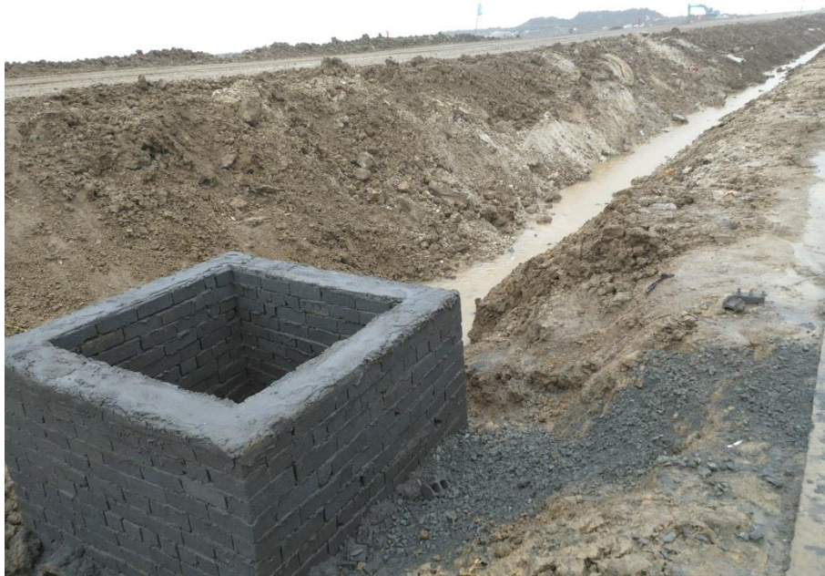
防浪墙沉砂池（2016年12月）
