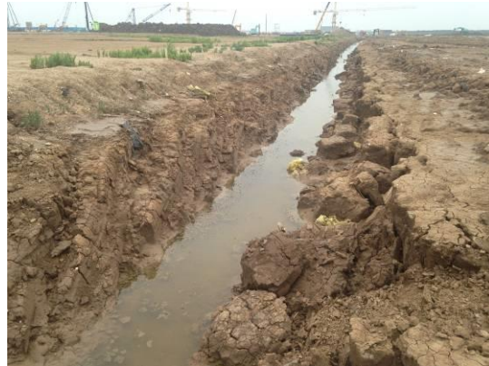
临时排水沟 (2016年5月)
