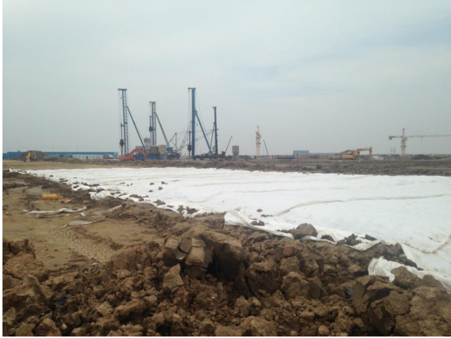
土工布苫盖（2016年7月）
