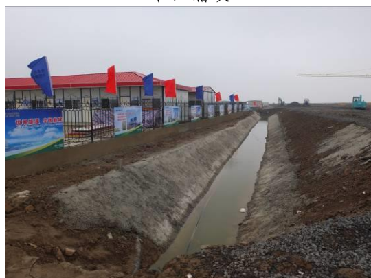
浆砌石排洪沟
