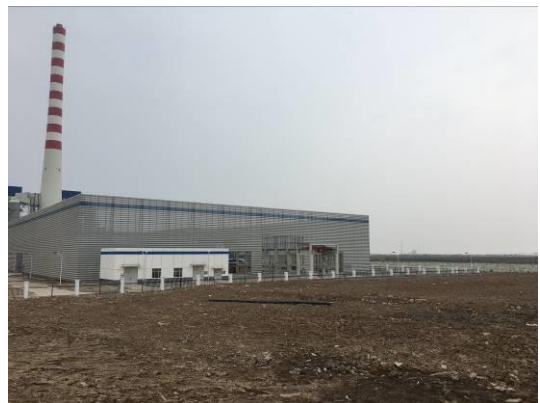
厂区裸露区域应尽快实施植被恢复措施
