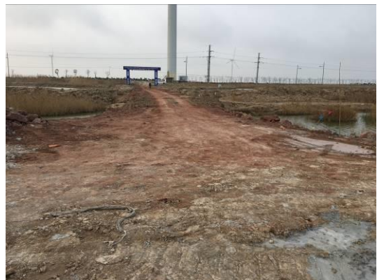
灰场区施工现状
