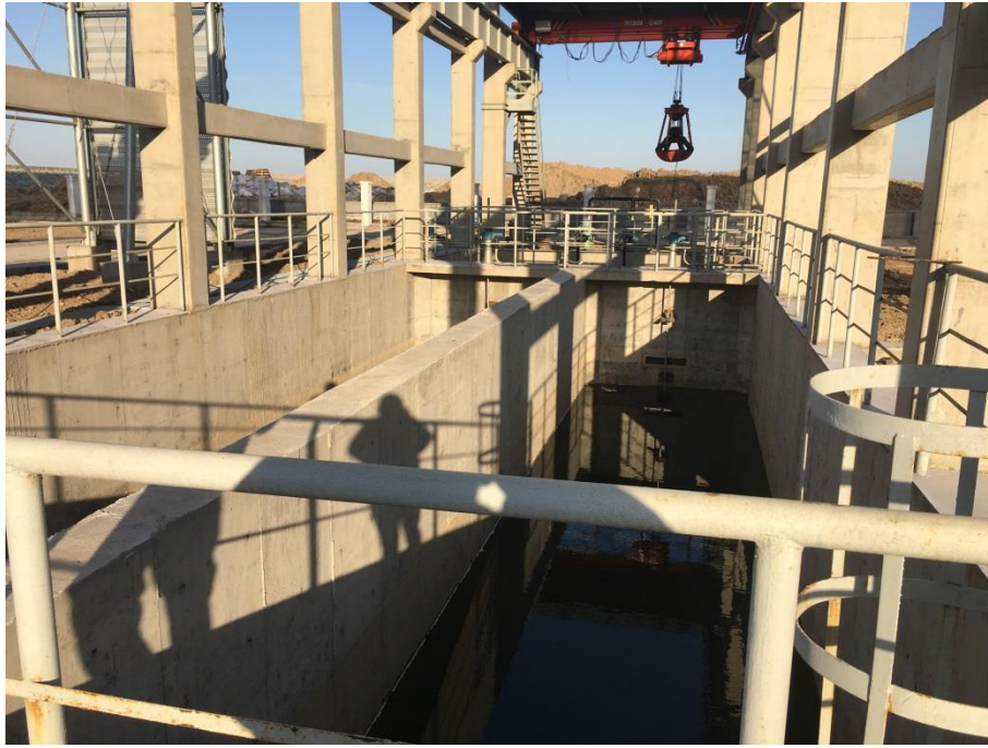
煤水沉清池（2017年12月）
