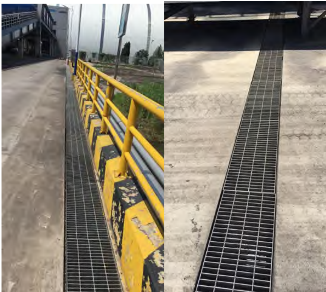
图 4-1 码头及引桥区排水沟
