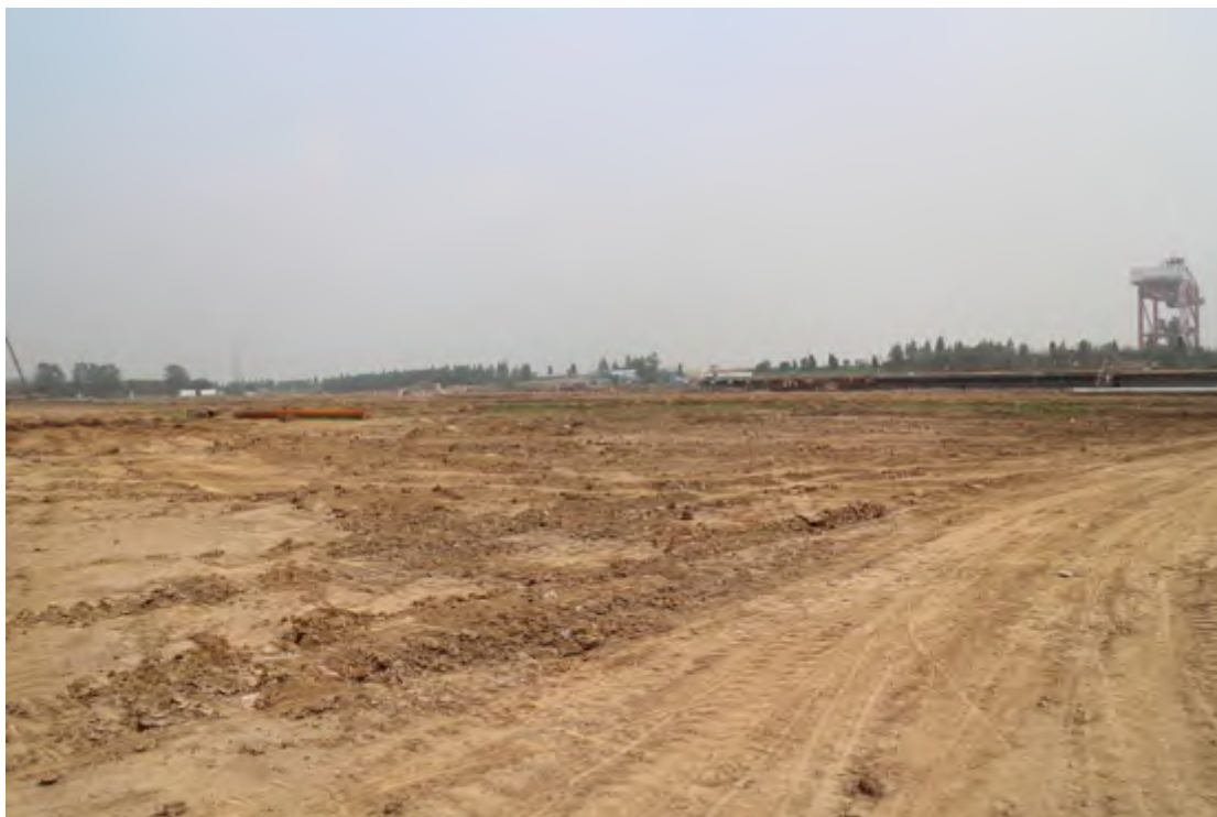
图 3-2 陆域堆场区地表裸露遇雨容易产生土壤侵蚀
