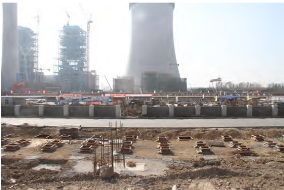
图 2-2 陆域堆场区施工正在紧张进行中
