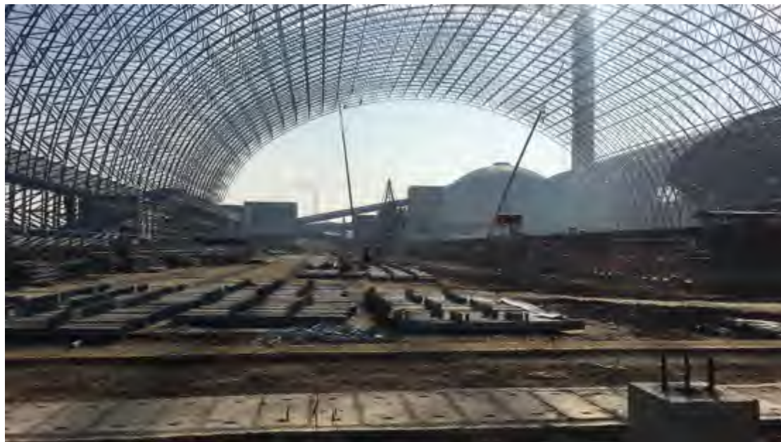
图 2-4 2018 年底陆域堆场区施工接近尾声
