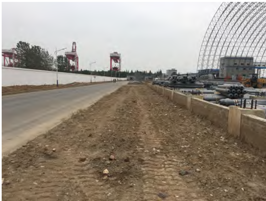
图 3-6 第四季度进场道路区已完成土地平整的裸露土地
