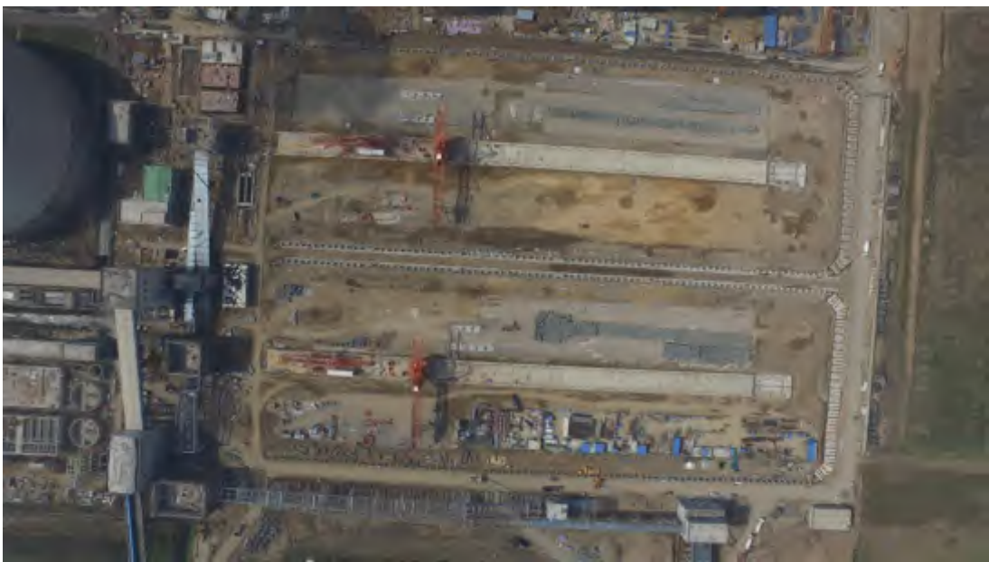
(a) 陆域堆场区施工情况
