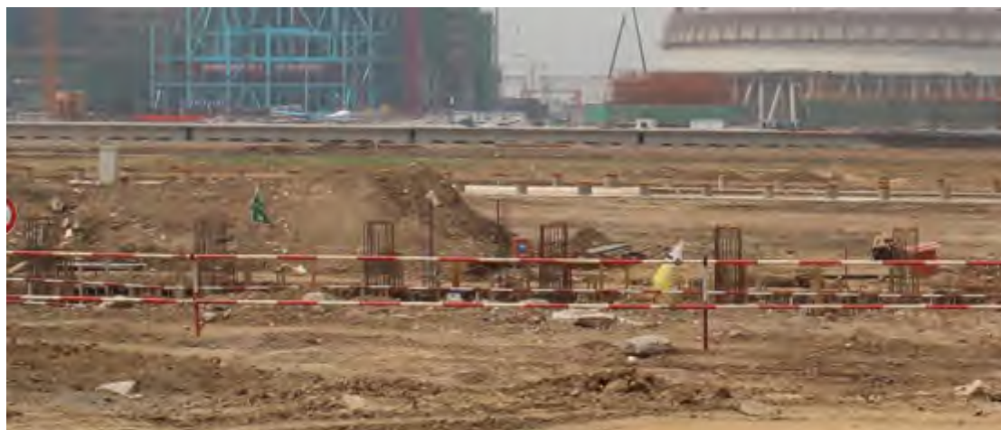
图 3-4 陆域堆场区第三季度施工对地表的扰动造成土壤流失
