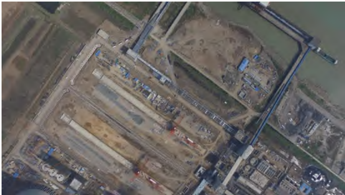
图 2-3 进场道路区施工基本完成（2018 年 3 月，无人机影像）
