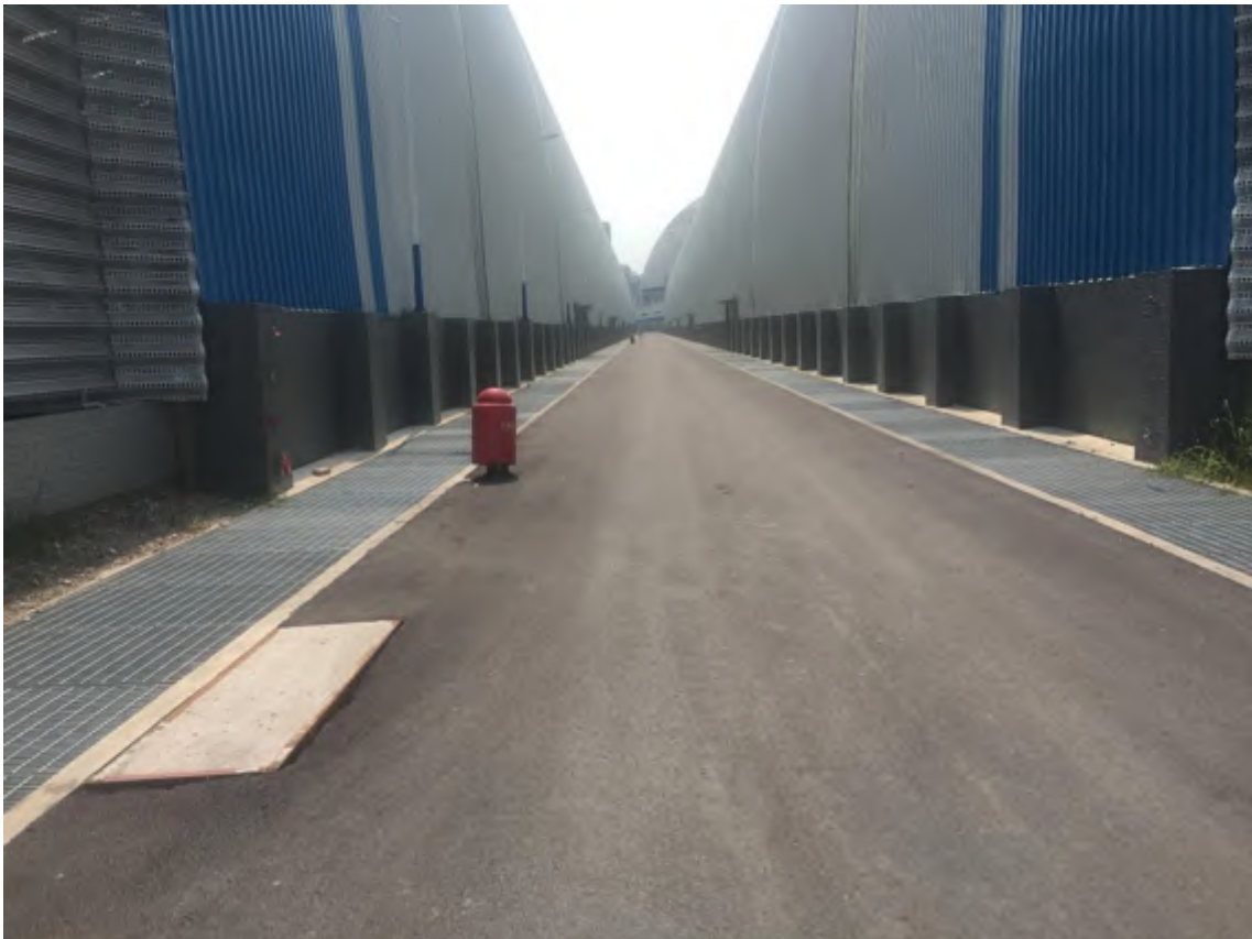
图 4-4 陆域堆场区排水明沟和挡煤墙
