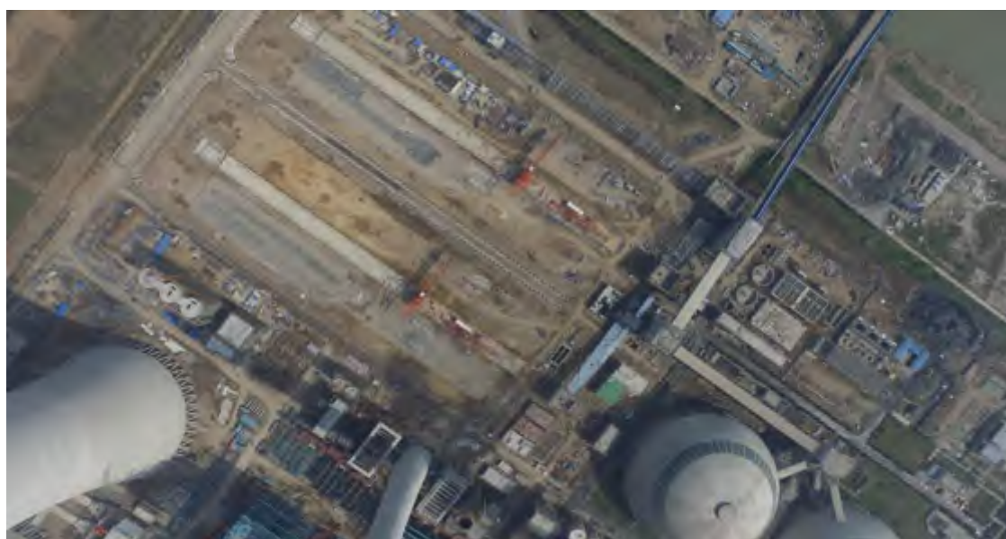
图 2-1 2018 年春季陆域堆场区正在紧张施工（2018 年 3 月无人机影像）
