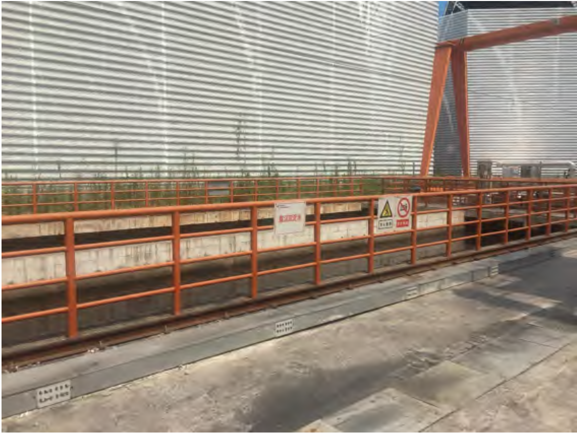
图 4-3 陆域堆场区沉煤池
