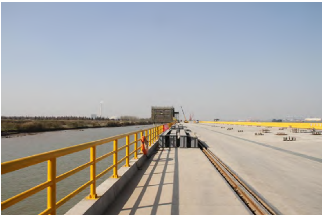
图 2-1 码头区施工已基本完成（2017 年 11 月）
