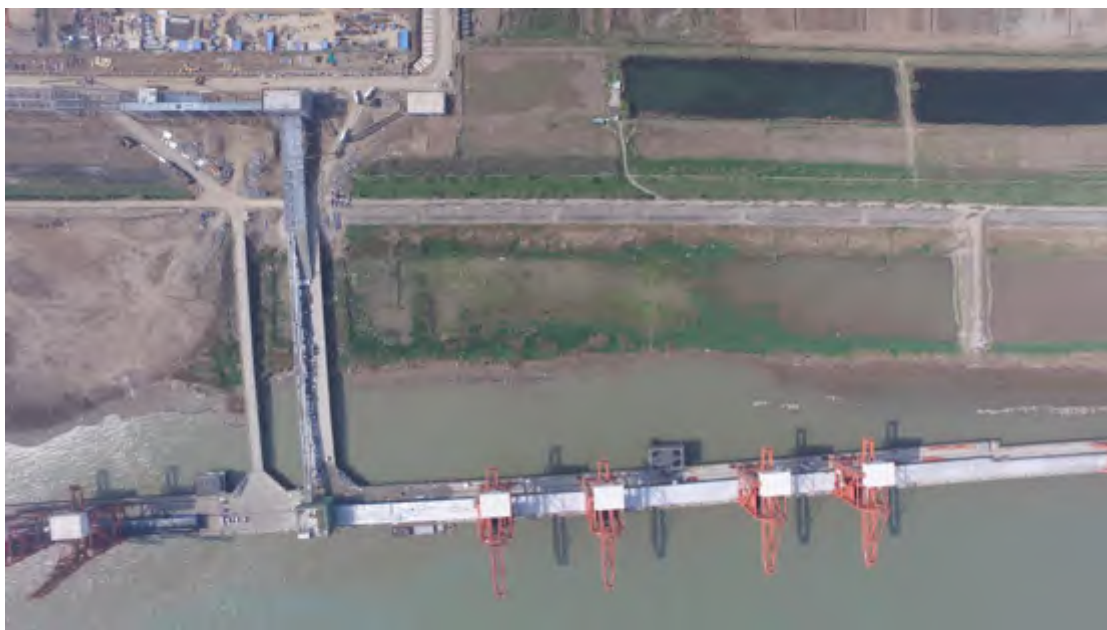
图 2-2 码头及引桥区基本完成（2018 年 3 月，无人机影像）
