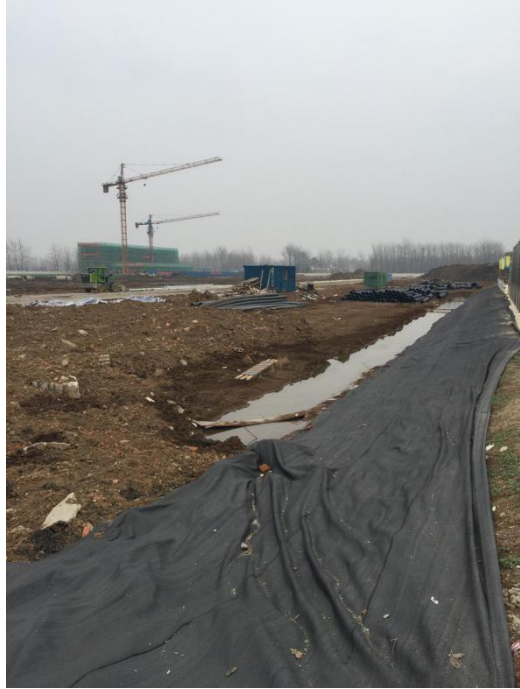
2017.1.19 储灰场施工场地苫盖
