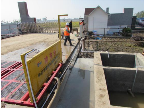
临时洗车平台
