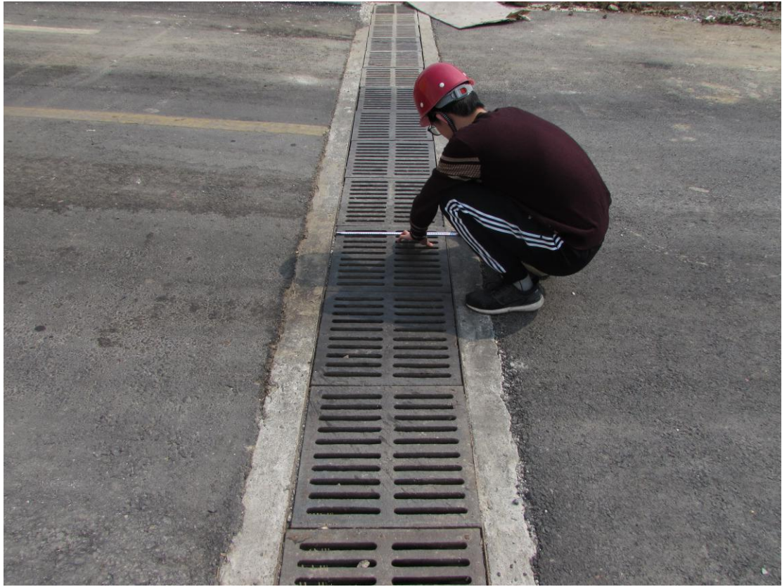
排水沟长度测量
