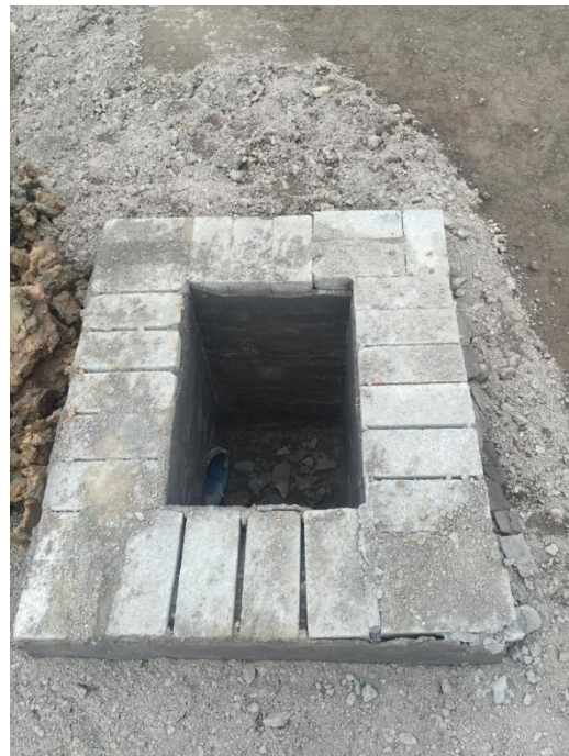
2017.3 施工临时排水沟
