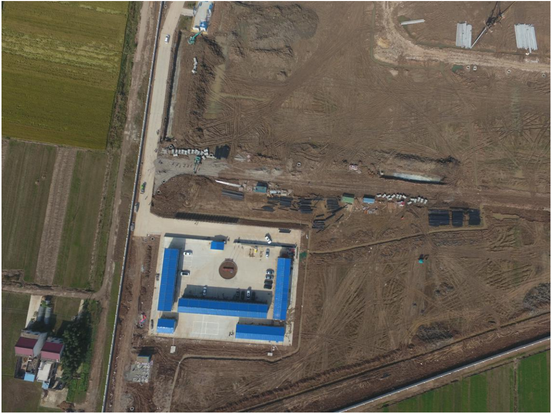
2016.11.3 无人机航拍场地平整
