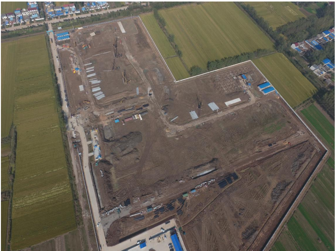
2016.11.3 无人机航拍场地平整
