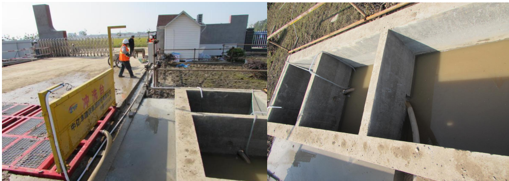
图 1-4 出入口临时洗车槽图（拍摄时间：2016.11.03）
