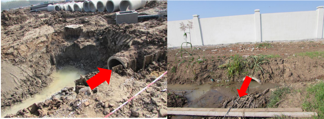
图 1-3 项目区排水设施图（拍摄时间：2016.11.03）
