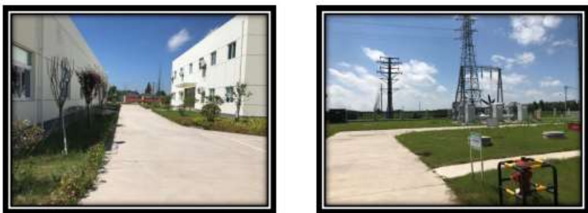
图 2 升压站区水土保持措施防治效果图
