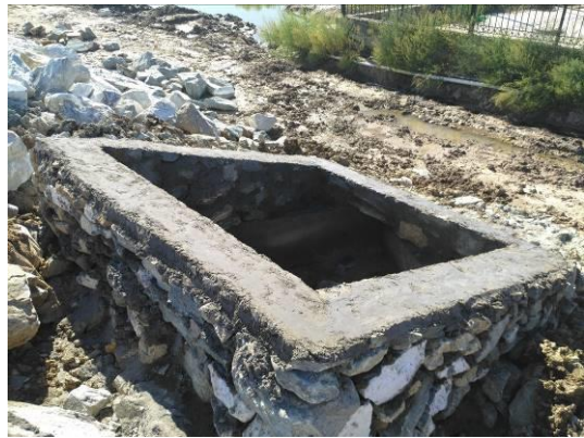
防浪墙沉砂池
