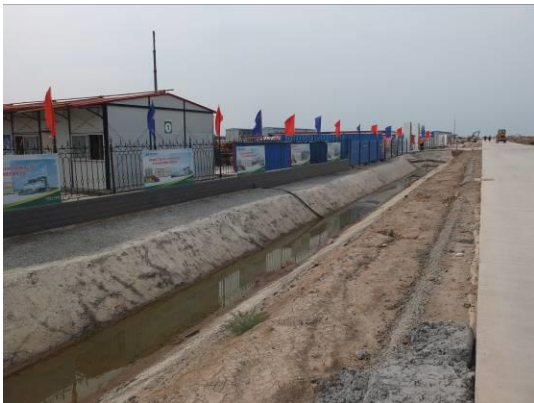
浆砌石排洪沟
