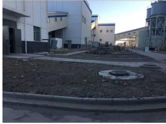
厂区场地平整、土地整治（2）
