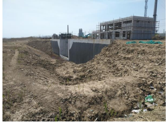
取水泵房施工
