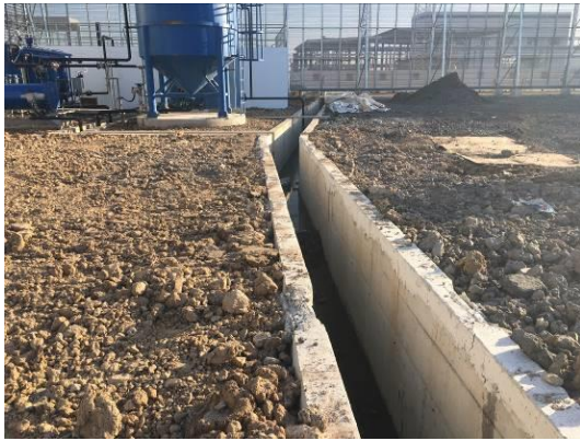
厂区钢筋混凝土沟
