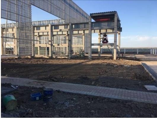
厂区场地平整、土地整治（1）
