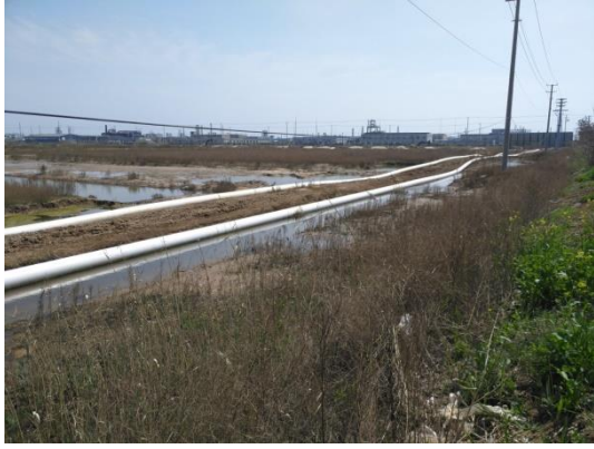
厂外管线区施工
