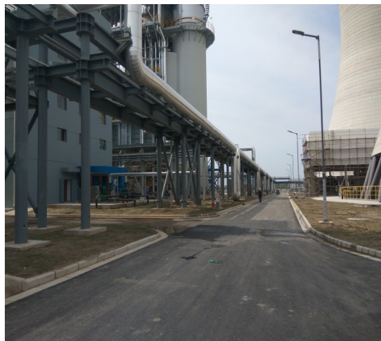
厂区设备安装
