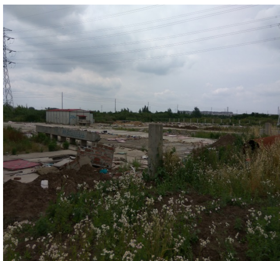
临时办公区整理
