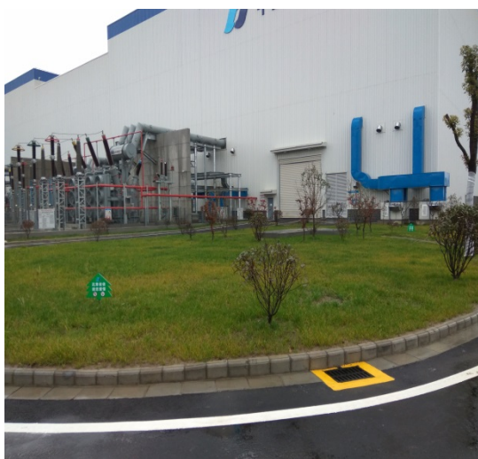
电厂区绿化、排水
