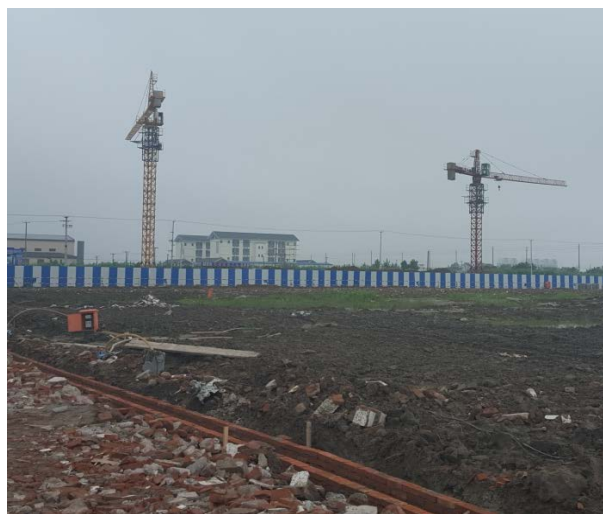
厂区临时防护、排水
