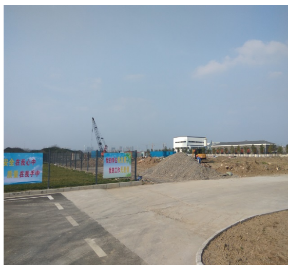
临时施工区整理
