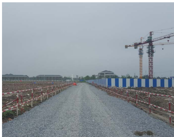
道路碎石铺垫
