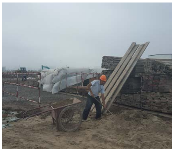
施工生产区材料堆放
