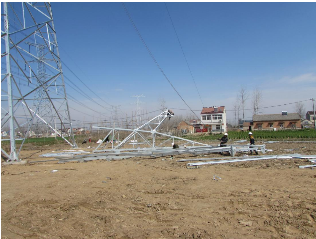
铁塔吊装, 7#塔组
