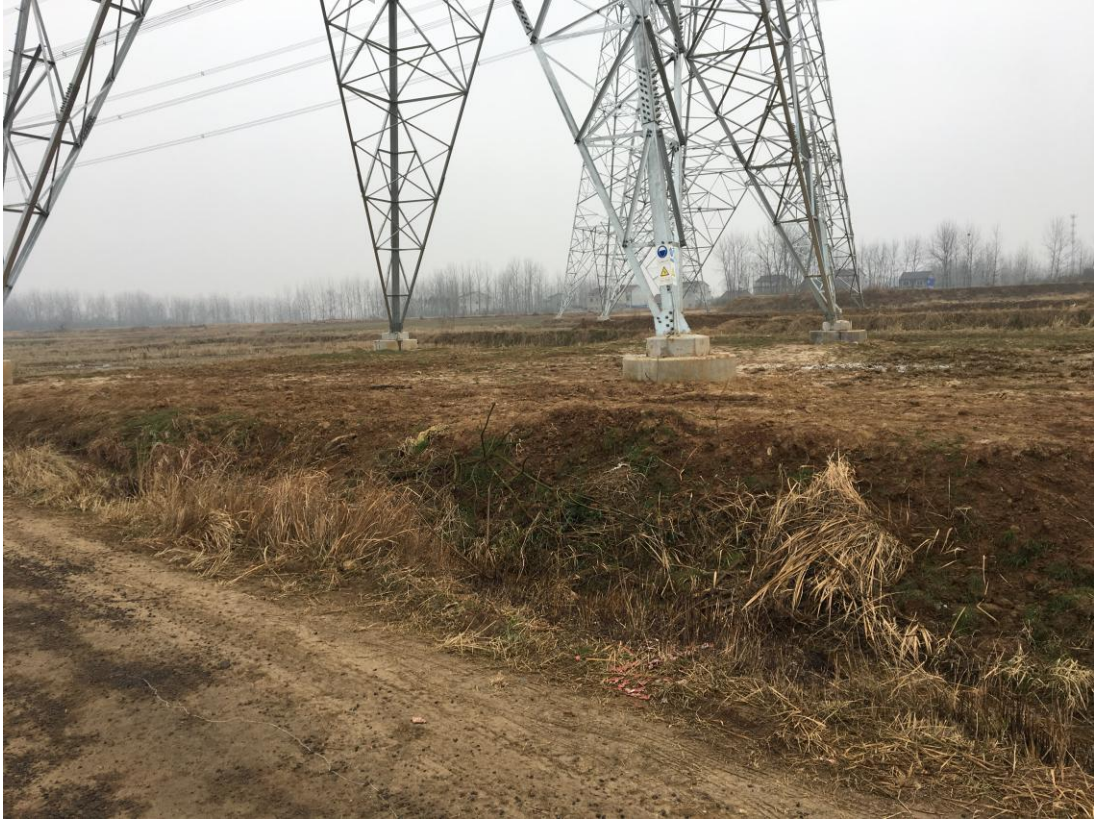
塔基土地整治，25#塔组
