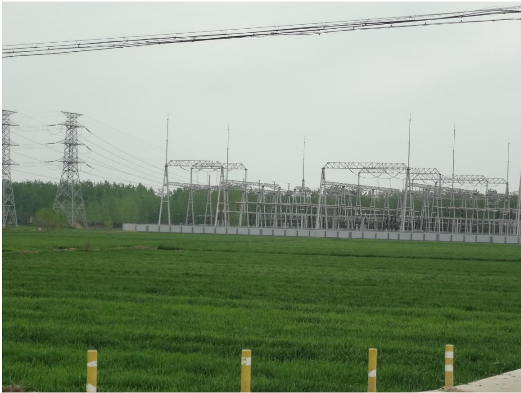
拟建塔基区，1#塔组
