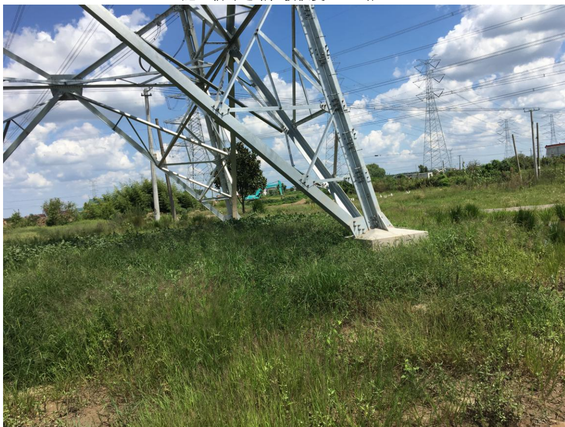
塔基区恢复植被，14#塔组
