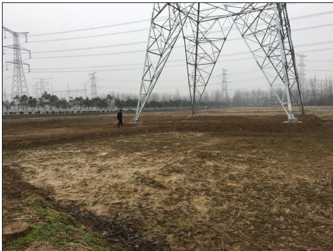
塔基区土地整治,3#塔组
