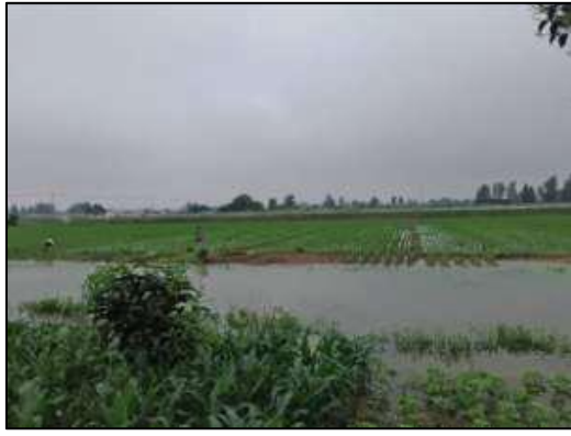
跨越及牵张场区
