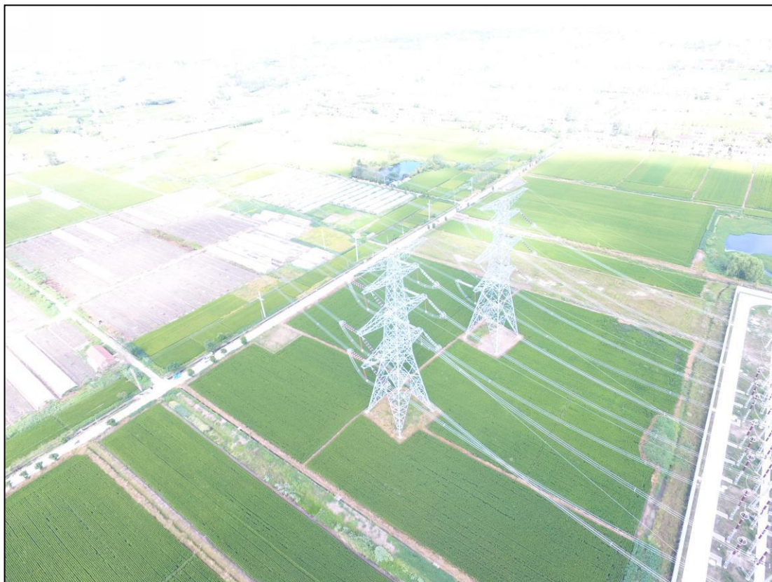
塔基区复耕，2#塔组
