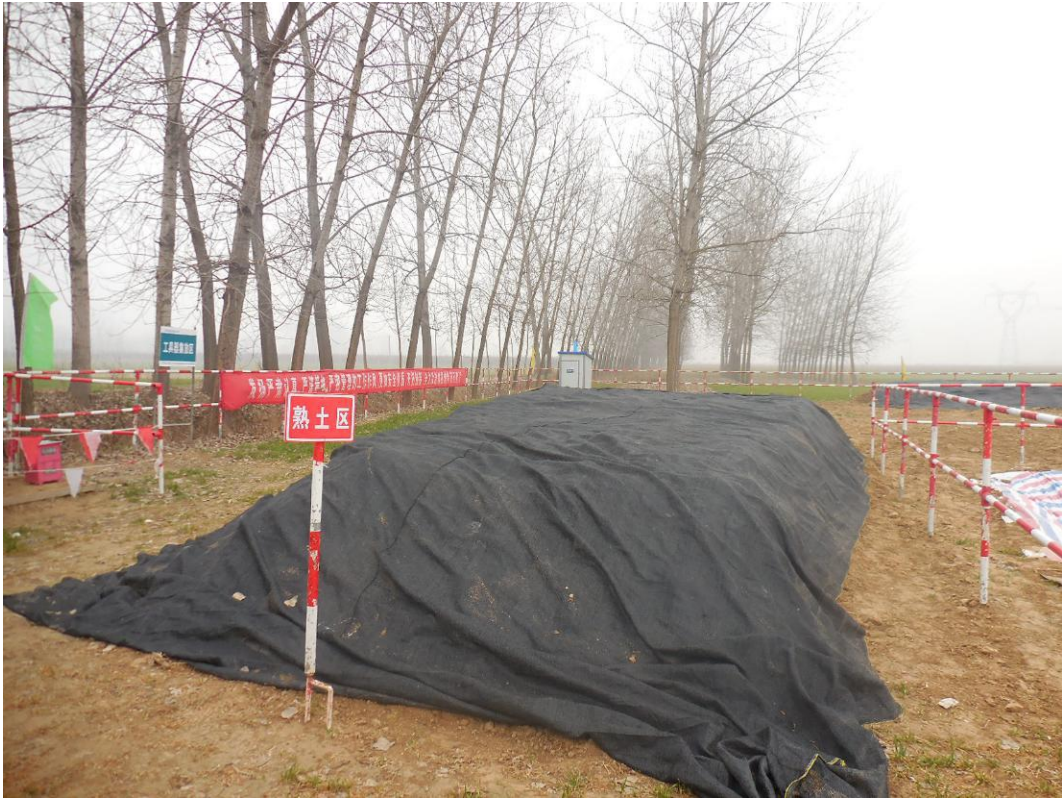
剥离的表土,3#塔组
