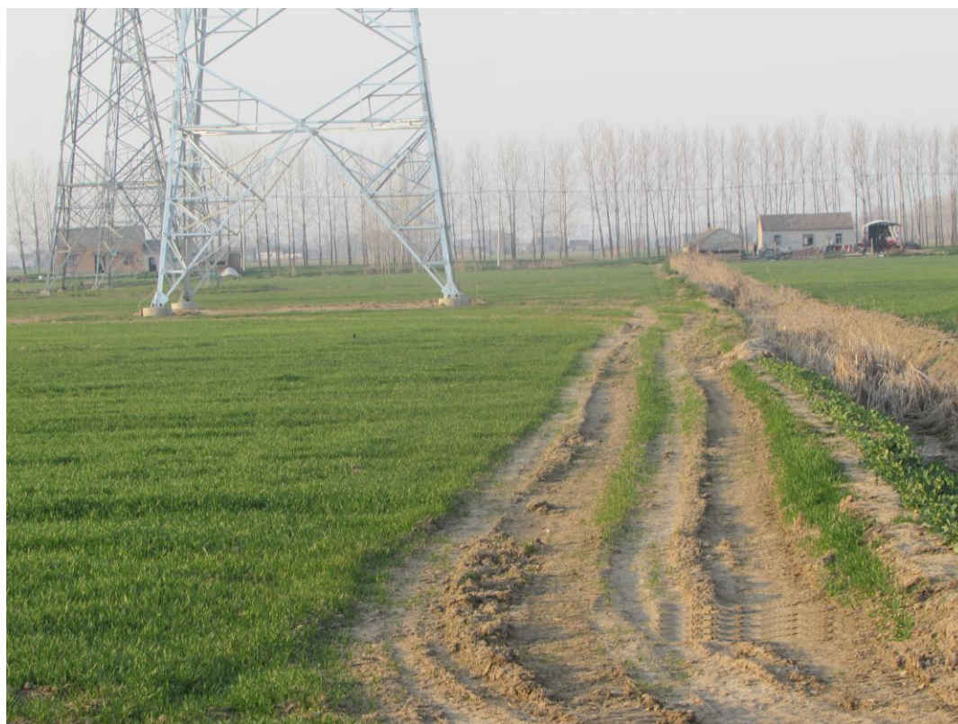
施工临时道路, 5#塔组
