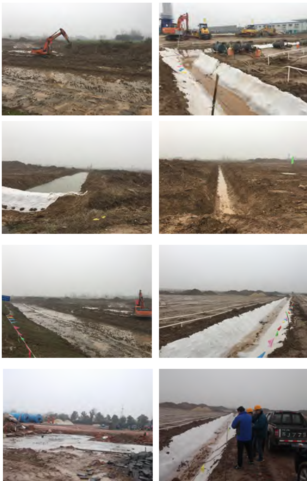
主体工程区施工现状
