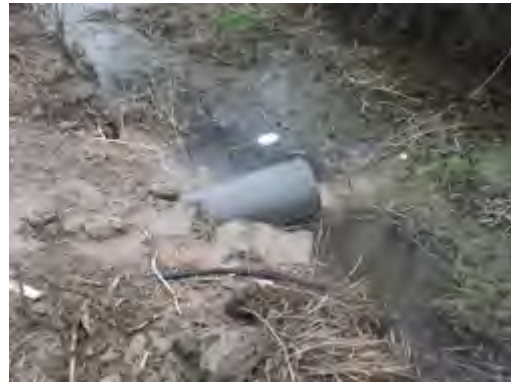
施工生产生活区含沙量监测点
