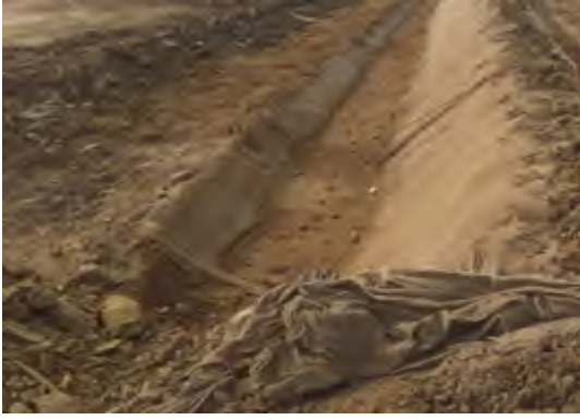
对货运工程区淤积及损坏的排水设施进行清理和修缮
