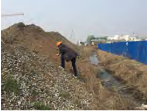
货运区临时堆土坡面
