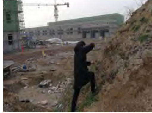
货运区临时堆土坡面
