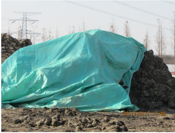
塔基基础施工阶段堆土彩条布全苫盖
