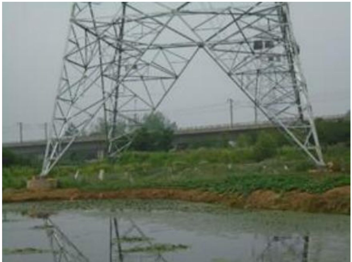
拍摄时间：2018年8月16日 拍摄地点：新建#102塔基（南京市浦口区）
