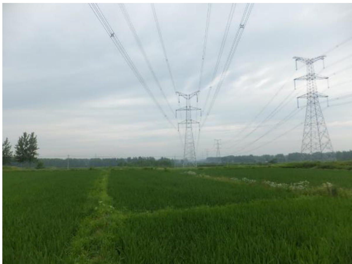
拍摄时间：2018年9月20日 拍摄地点：#20牵张场（滁州市来安县）
