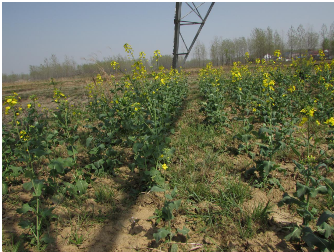
拍摄时间：2018年3月28日 拍摄地点：新建#76塔基塔腿部位（南京市六合区）
