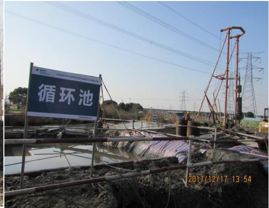
塔基基础施工阶段泥浆池布设
