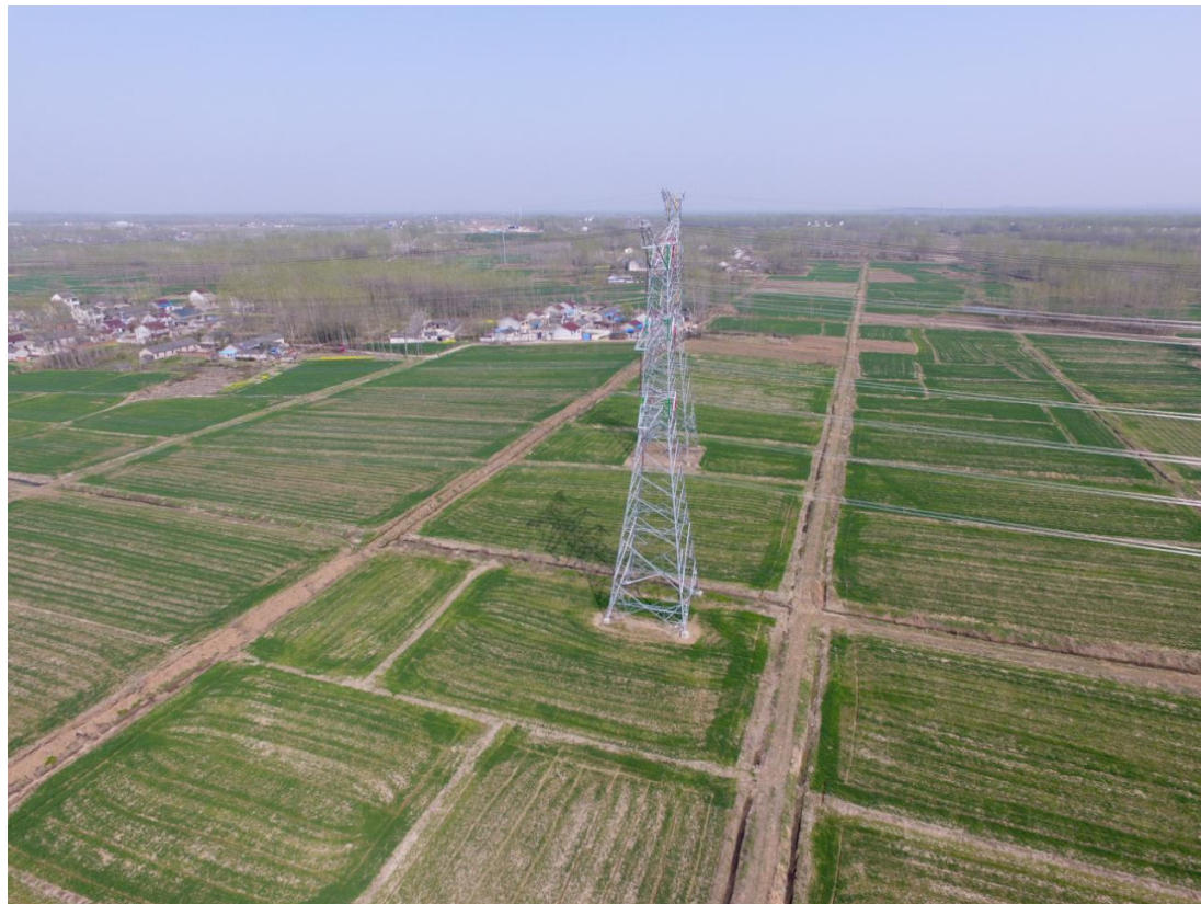
拍摄时间：2018年3月28日 拍摄地点：新建#76塔基整体（南京市六合区）
