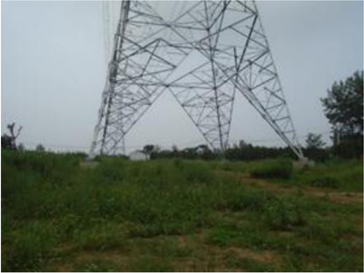
拍摄时间：2018年8月16日 拍摄地点：新建#101塔基（南京市浦口区）
