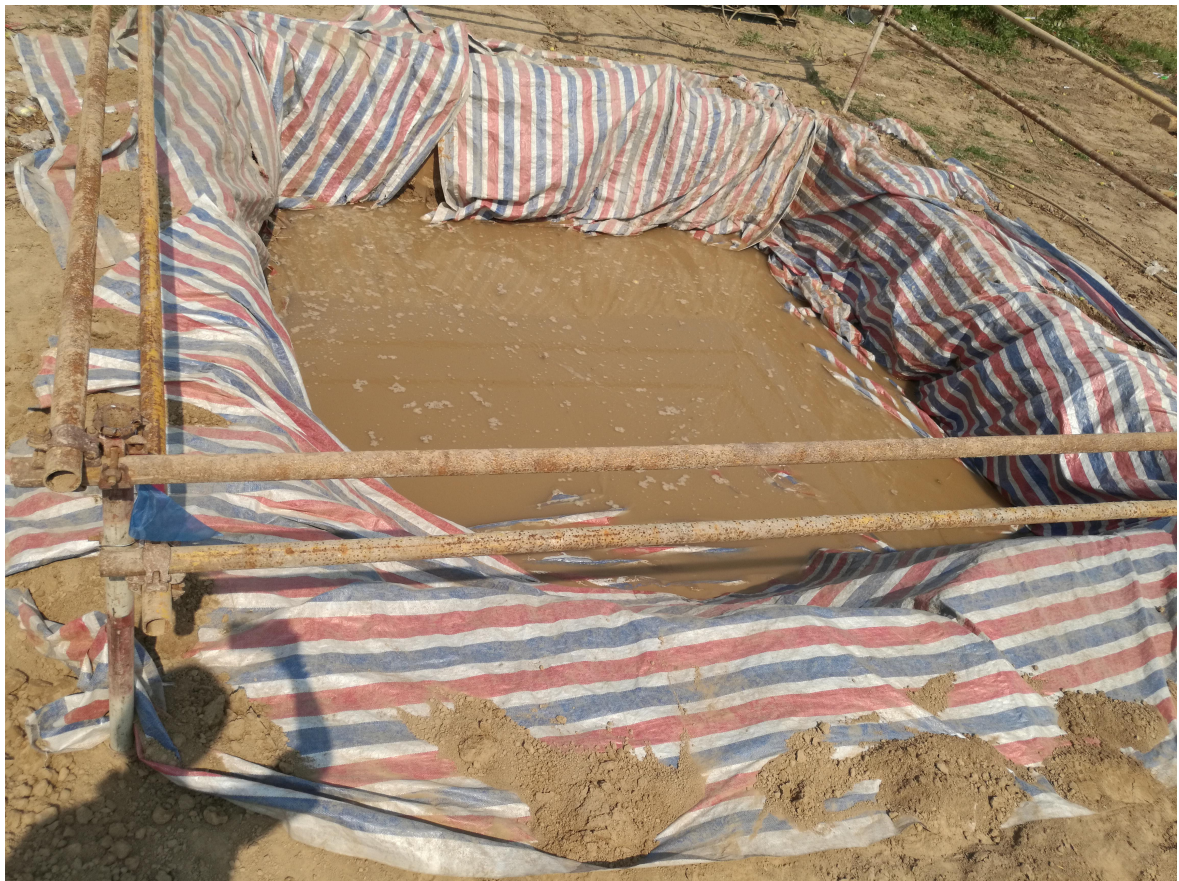
拍摄时间：2017年11月22日 拍摄地点：新建#101塔基沉砂池（南京市浦口区）
