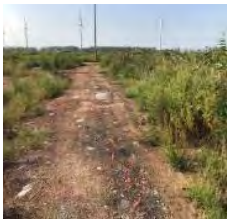
附图 13 施工道路
