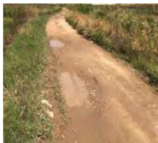
附图 12 施工道路
