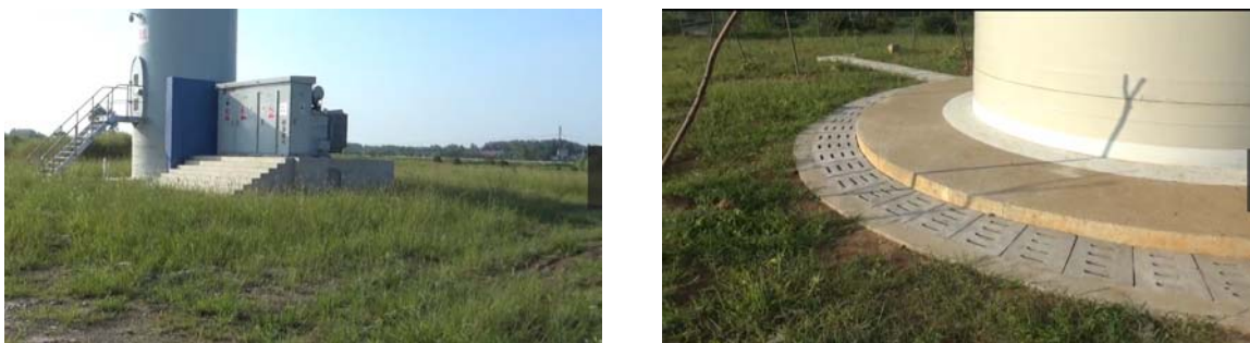
图 1 风机场地区水土保持措施防治效果图
