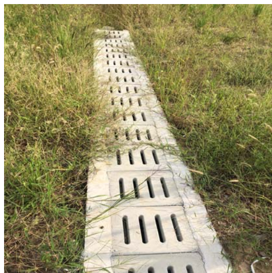
图 2 风机场区排水沟
