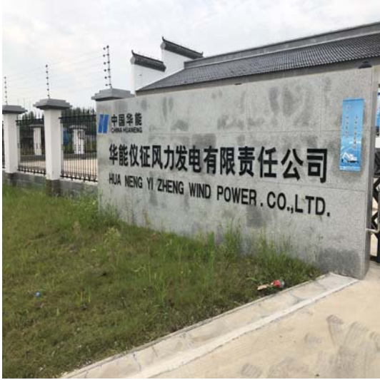
图 5 升压站区绿化
