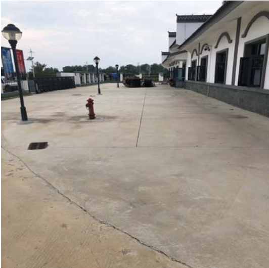
图 7 升压站区场内硬化
