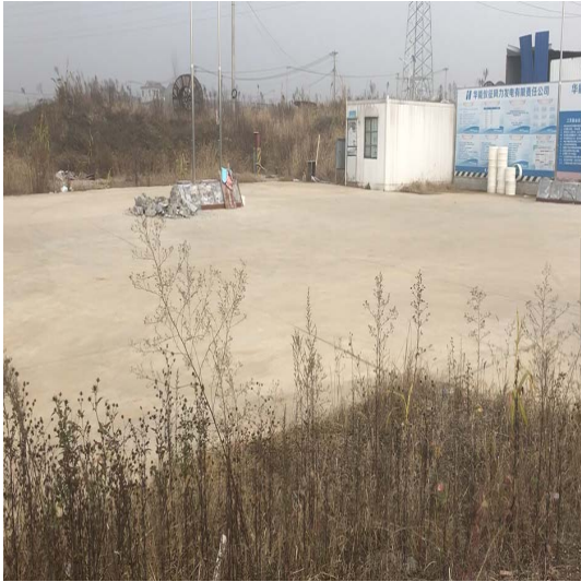
图11 施工生产生活区硬化
