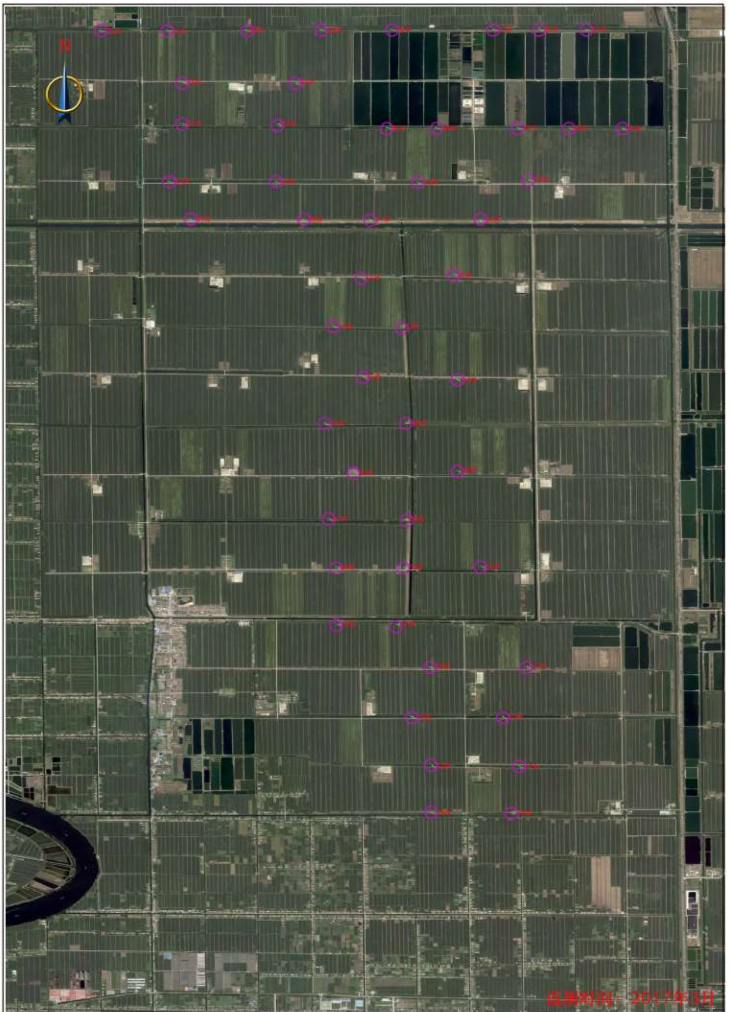
附图7 江苏国信盐城射阳临海农场风电场二期（100MW）项目竣工后遥感图
