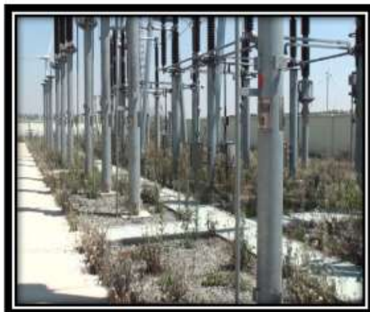
附图 2 升压站碎石铺垫
