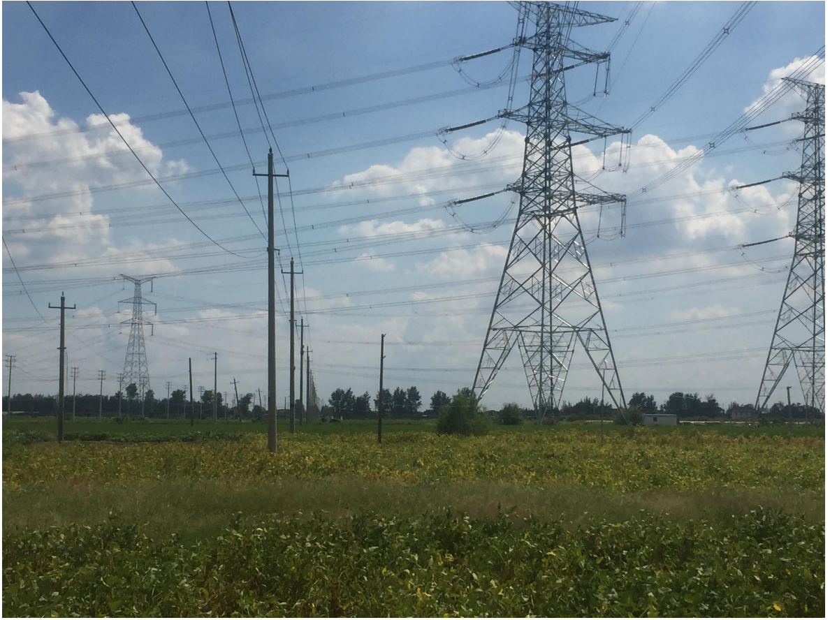
牵张场（1#塔组附近）
