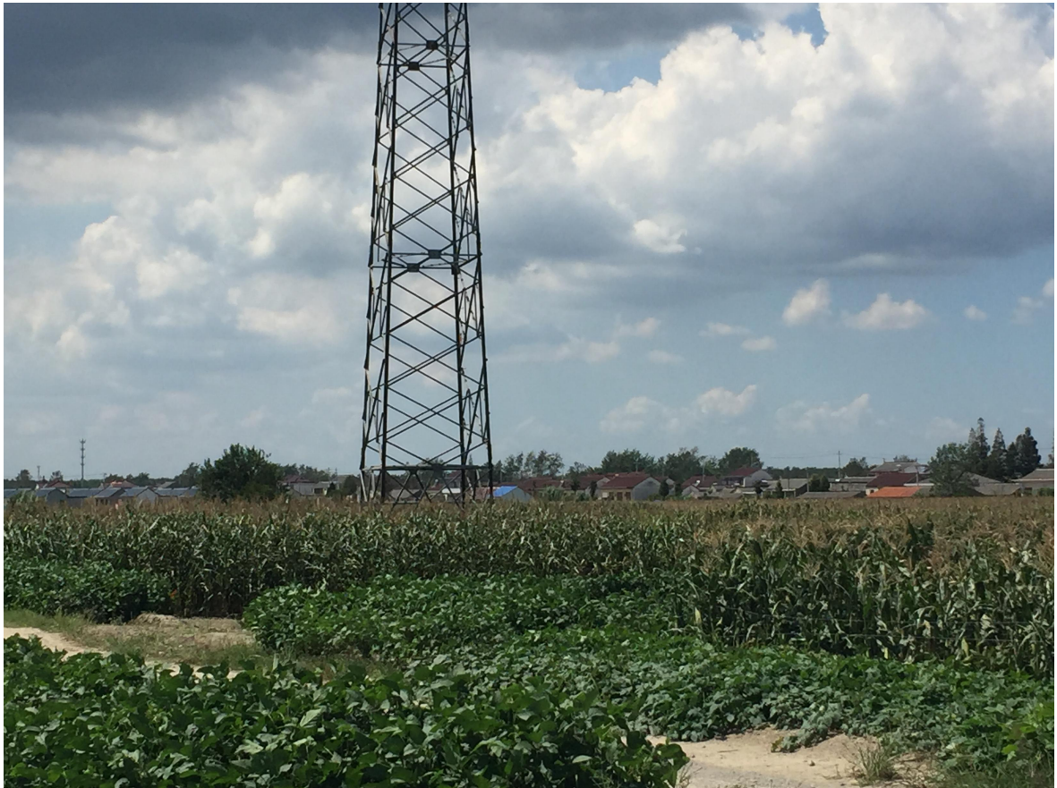
施工临时道路（22#塔组）
