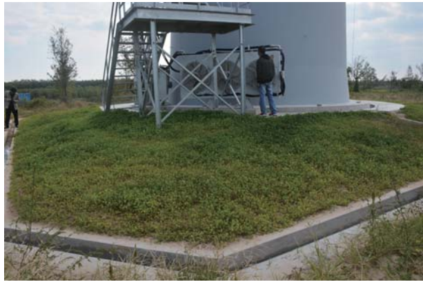
风机场区绿化与排水
