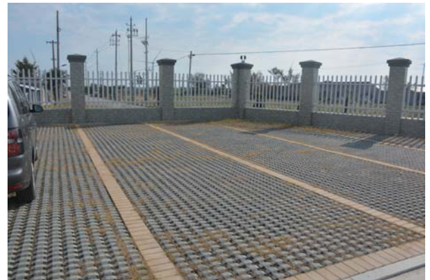
升压站停车场
